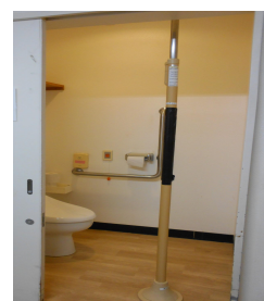
トイレ内に手すりを設置
